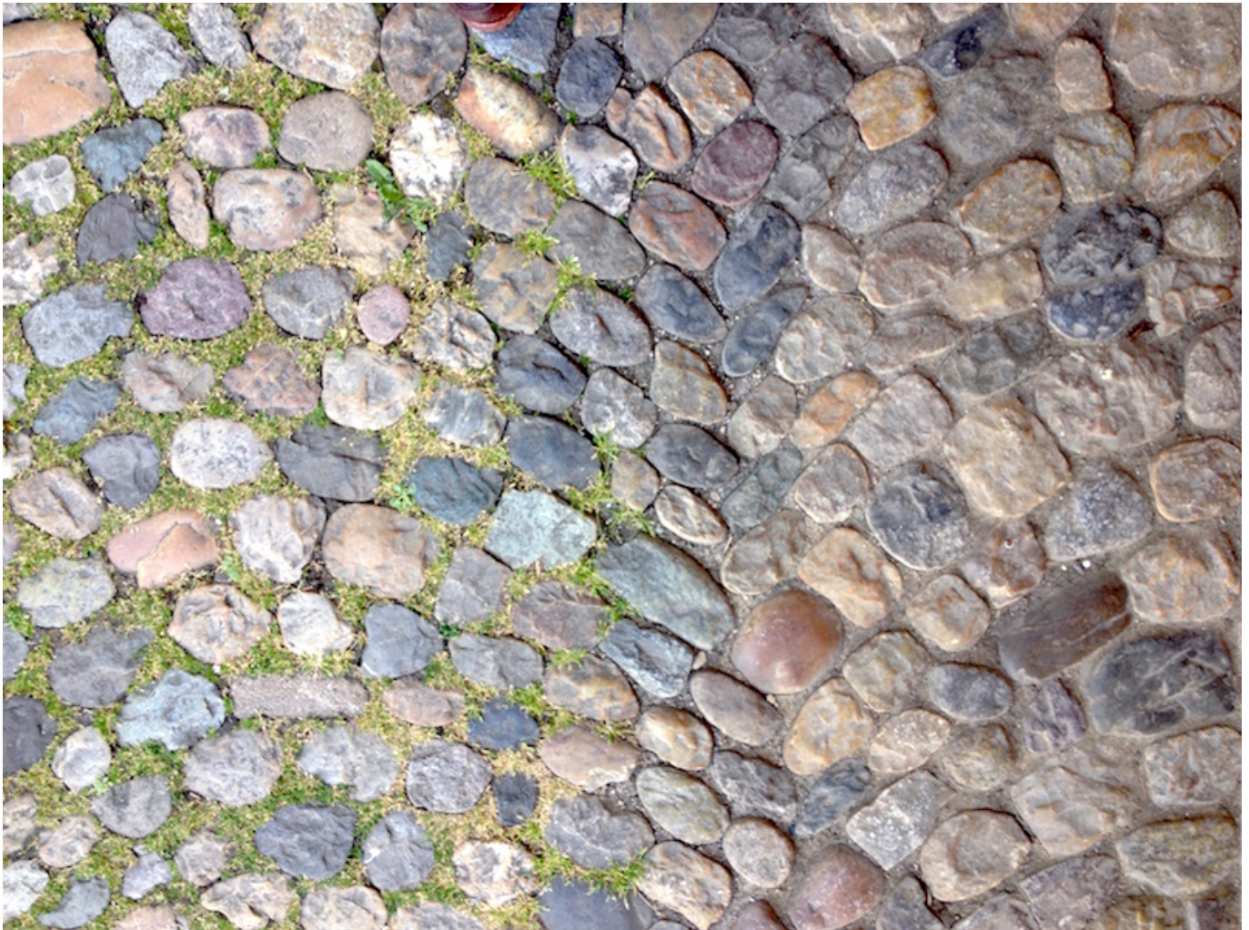
Abb. 1: Detailaufnahme der Grenzlinie zwischen mit Gras bewachsenen und kahlen Pflasterfugen, senkrechter Blickwinkel
